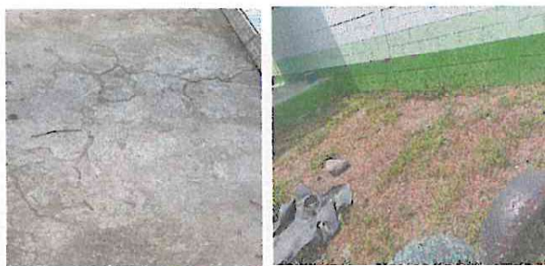
Foto 2: sustitucion de plancha de cemento
