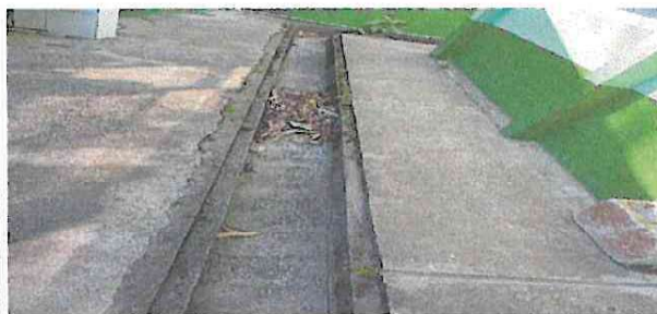
Foto 6: sustitucion de regillas en mal estado desde hace años expuestas y se retiraron por seguridad y evitar accidentes.
