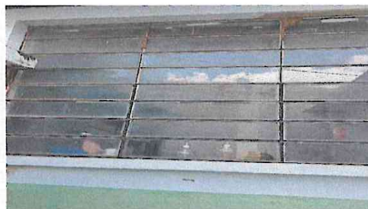
Foto 4: sustitucion de ventanas
